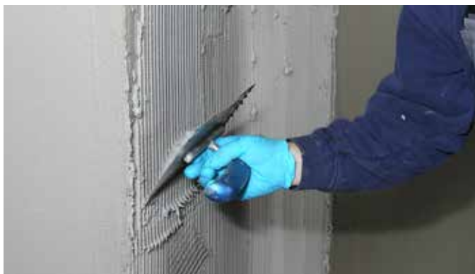
Kellarin sisäpuolinen vedeneristys
